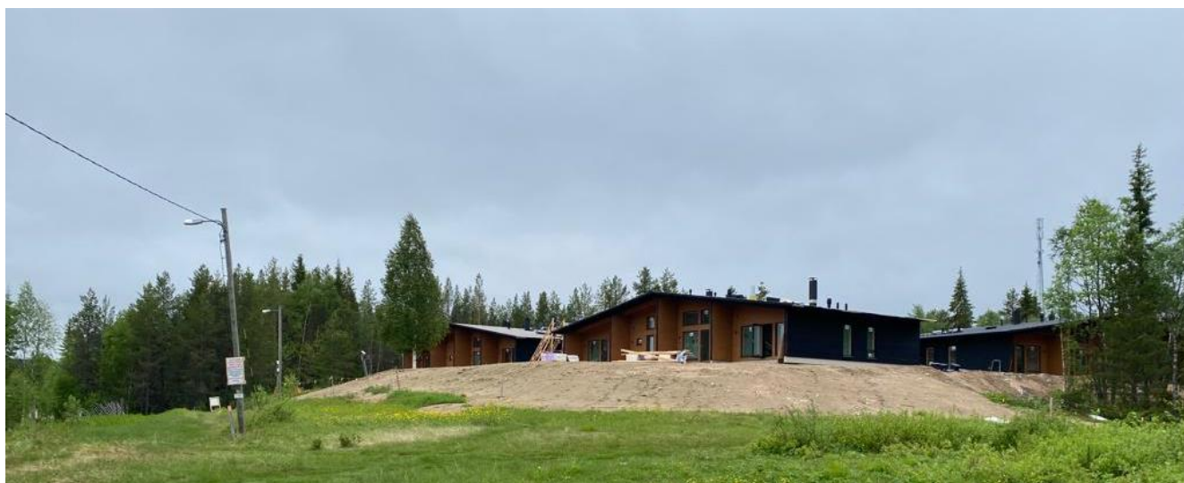
Kuva 6. Riemuliiterin tilalle on rakennettu 3 pienrivitaloa, joissa on loivat harjakatot. Kuva kaavamuutosalueen itäreunassa kulkevalta Rantatieltä länteen. H. Lokio 2022.
